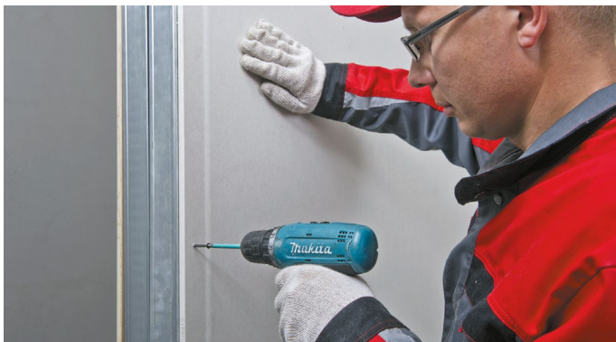
Рис. 13. Обшивка стен листами ГКЛ
