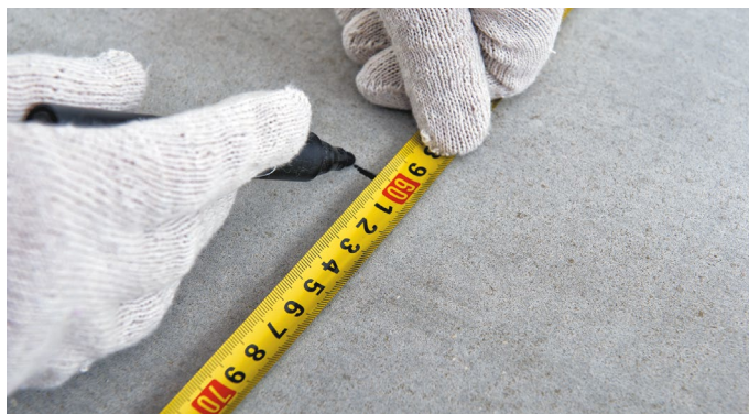
Рис. 2. Разметка основания
