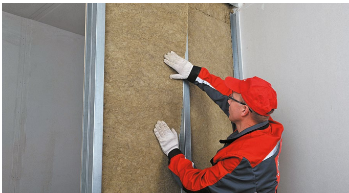
Рис. 6. Монтаж тепло-, звукоизоляционных плит
