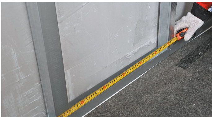
Рис. 11. Установка направляющего и стоечного профилей
