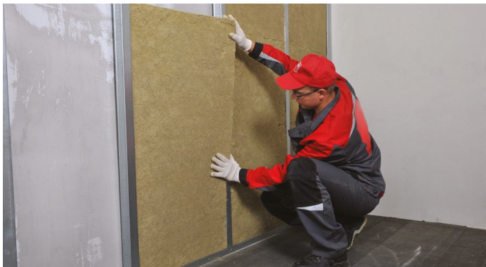
Рис. 12. Монтаж тепло-, звукоизоляционных плит
