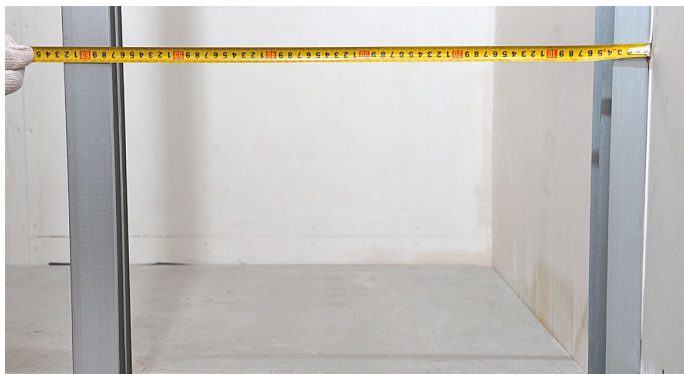
Рис. 4. Установка стоечного профиля
