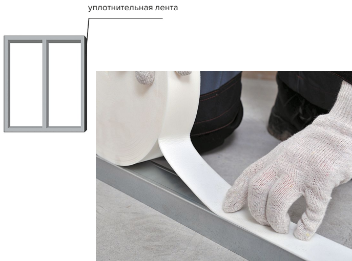
Рис. 3. Схема расположения и приклейка уплотнительной ленты в каркасе
