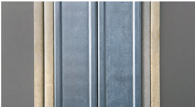
Рис. 7. Обшивка второй стороны перегородки листами ГКЛ
