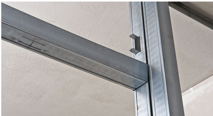
Рис. 4. Установка стоечного профиля (продолжение)
